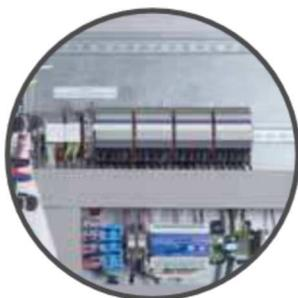
Unsere zentralen Stromversorgungssysteme können in verschiedenen Gehäusegrößen bzw. -arten geliefert werden. Alle Gehäuse sind normkonforme Eigenentwicklungen und sind unter Beachtung einer Vielzahl von praktischen Anforderungen gestaltet. (EN 50171; EN 50272-2). Prinzipiell sind die Elektronikkomponenten von der Batterie getrennt untergebracht.
